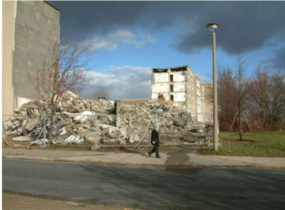
Viele Wohnungen in Görlitz stehen leer. Abriss in der Plattenbausiedlung Görlitz-Königshufen, 2004. Foto: © Photosammlung H. B.
