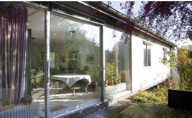
Fertighaus Winsen Luhe, erbaut 1966
