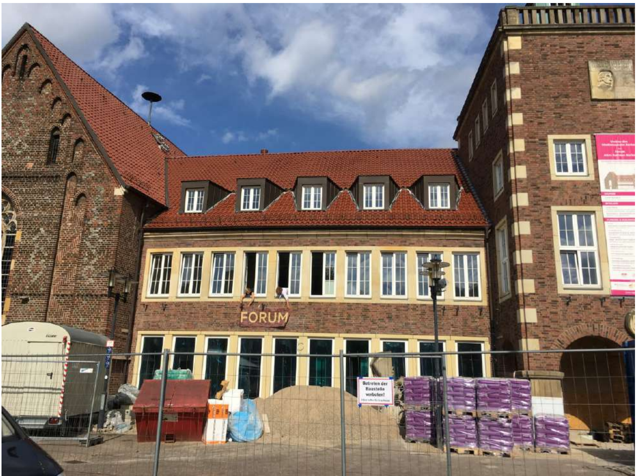
Abb. 1: Die Fassade des FARB Forum Altes Rathaus Borken während des Umbaus, 2018. © Stadt Borken.
