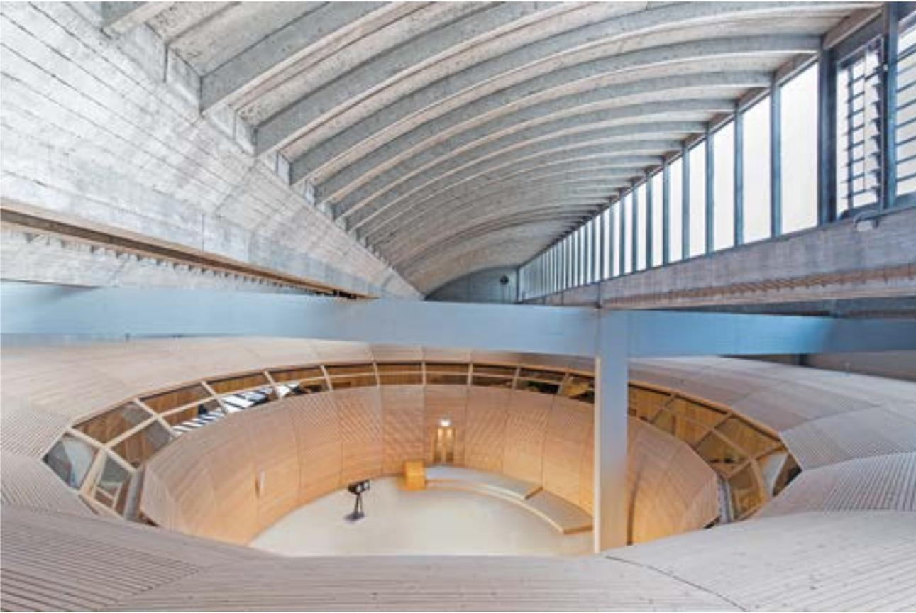
ABB. 3 — Inhouse-Konstruktion mit RWA-Fenstern (Fenster mit Rauch- und Wärmeabzugsfunktion) unter dem Dach der ehemaligen Blumengroßmarkthalle. Foto und © Nadja Rentzsch.
