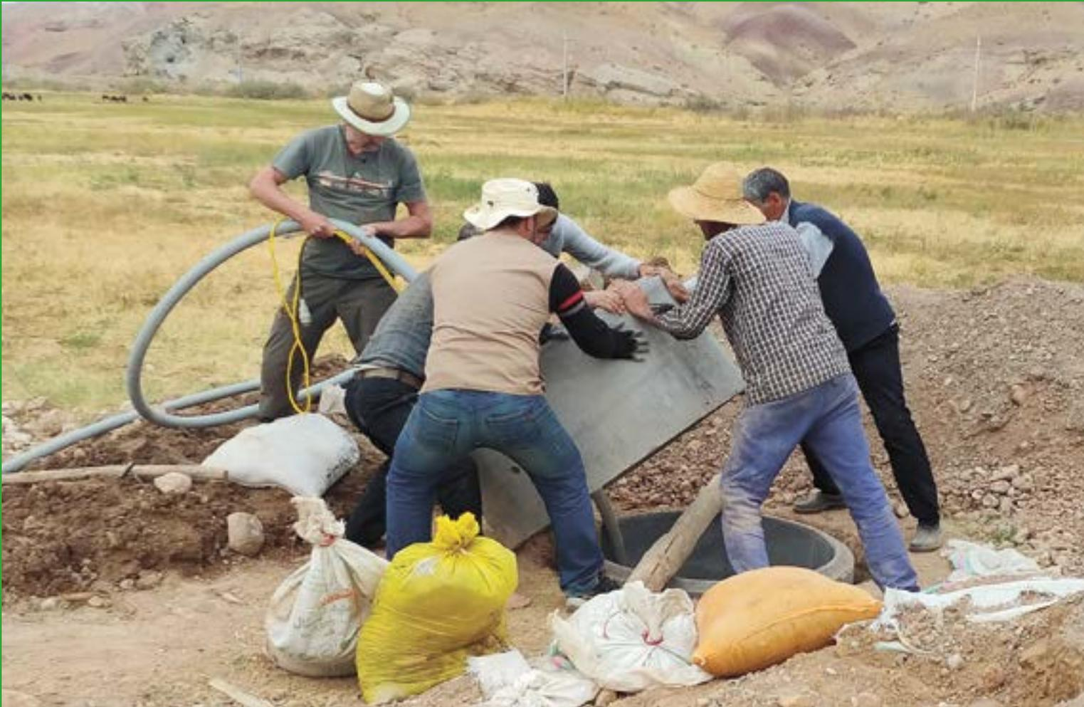
ABB. 1 — Nach der Lokalisierung einer geeigneten wasserführenden Schicht durch Geoelektrik, wurde an dieser Stelle nach lokaler Methode in Handarbeit ein Brunnen gegraben. Danach wird der Brunnen auf ausreichenden Wassernachfluss getestet und das Wasser auf Schadstoffe analysiert. Foto: Natascha Bagherpour Kashani.
